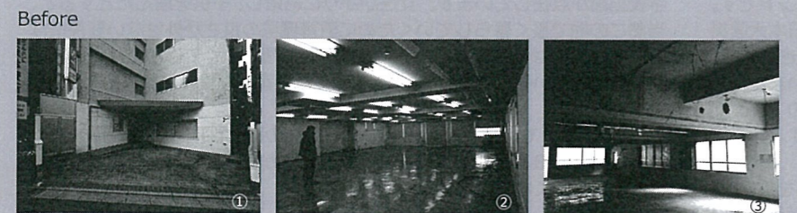
①エントランスポーチの庇は改修で撤去②広々とした事務所は耐震診断を実施して改修には問題なかった③天井は撤去され、梁のスリーブは味わいとしてそのまま残された
